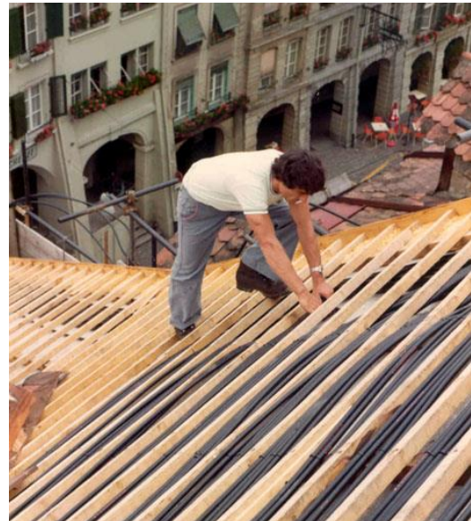
Bild 7-4 Dachkollektor zwischen den Sparren unter der Ziegelabdeckung, 1978 [Grimm 2007]
