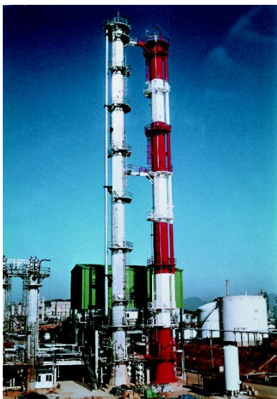
Bild 7-18 Eine der ersten Rektifikationsanlagen mit Brüdenkompression, 1986 [Sulzer Chemtech, CH-8404 Winterthur]
