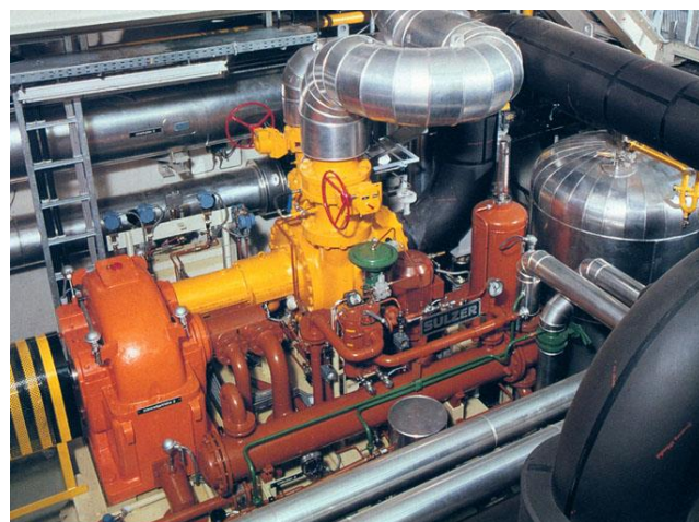
Bild 5-16 Wärmepumpeneinheit seit 1988 [Friothersm 2008]
