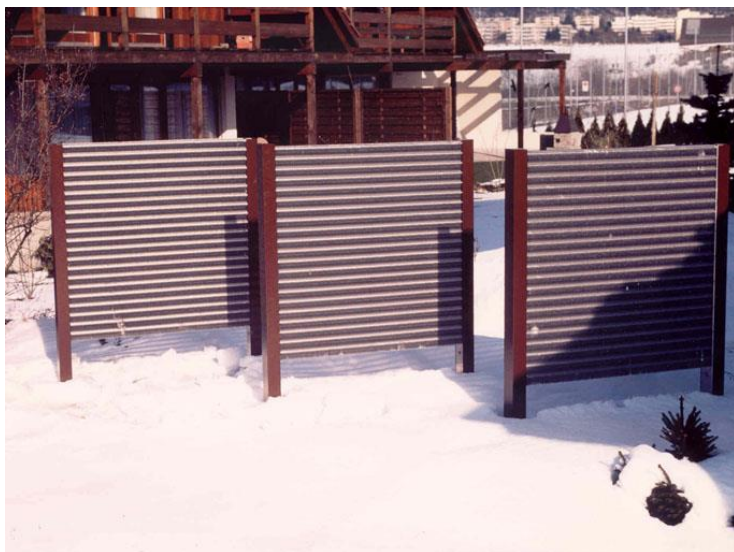
Bild 7-6 Energiezaun-Verdampfer, um 1980 Neucalora [Grimm 2007]
