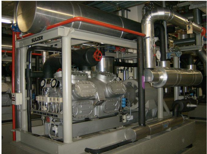
Bild 7-10 Eine der Sulzer-Wärmepumpeneinheiten beim Bahnhof Luzern, 1984 installiert. 1990 auf Ammoniakbetrieb umgebaut [Axima, CH-6010 Kriens]
