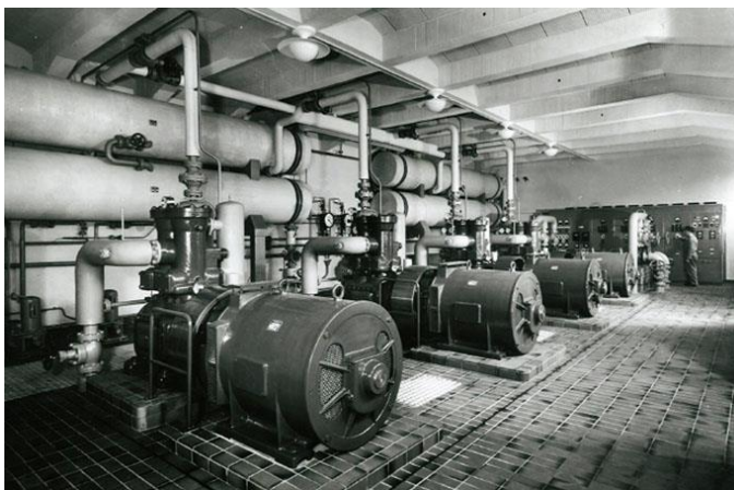
Bild 5-22 Maschinenhalle mit Wärmepumpen und Kondensatoren, 1943 [Eberhard 2007]
