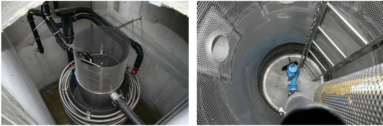
Bild 7-15 Neueste Version (2007) des FEKA-Tanks für die Wärmerückgewinnung aus häuslichem Rohabwasser. Links Wärmeübertragerrohre, rechts Sedimentationszone. Fotos Eulachhof Winterthur [Kalberer 2007]
