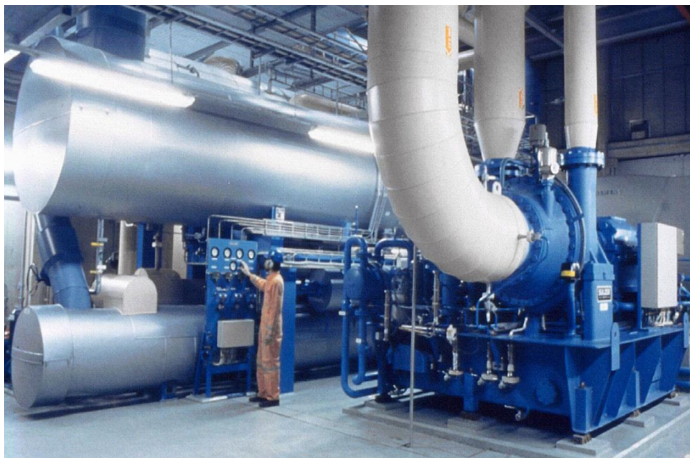
Bild 7-14 Eine der sechs 30 MW Wärmepumpen mit Radialkompressoren des Värtan Ropsten Fernheizungssystem von Stockholm [Friothersm 2008]
