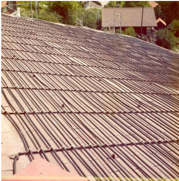
Bild 7-3 Dachkollektor mit unverglasten Polyethylenrohren auf dem Dach, 1978 [Grimm 2007]
