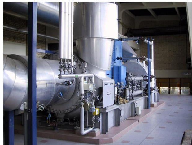
Bild 5-32 Neue Radialkompressoren für die Verdampfungskristallisation in Aarberg, 1991 [Zuckerfabrik, CH-3270 Aarberg]
