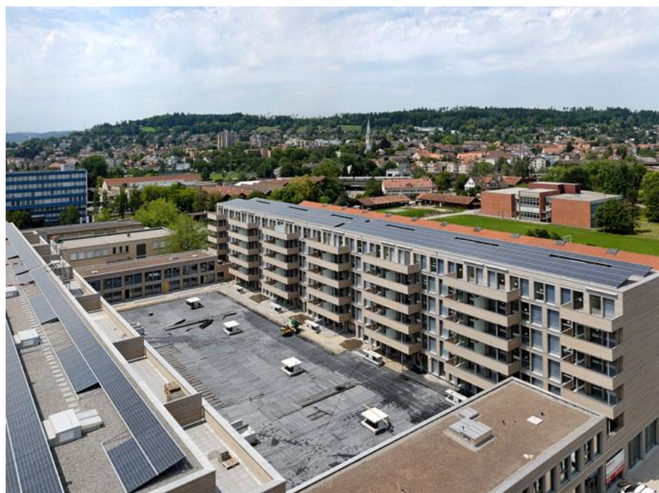
Bild 8-9 Eulachhof Winterthur mit PV-Zellen zum Antrieb der Wärmepumpe und der kontrollierten Belüftung. [Allreal, CH-8050 Zürich]
