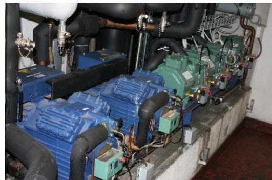
Bild 8-22: Kompressor des untersuchten Anlagebeispiels [KWT, CH-3123 Belp]
