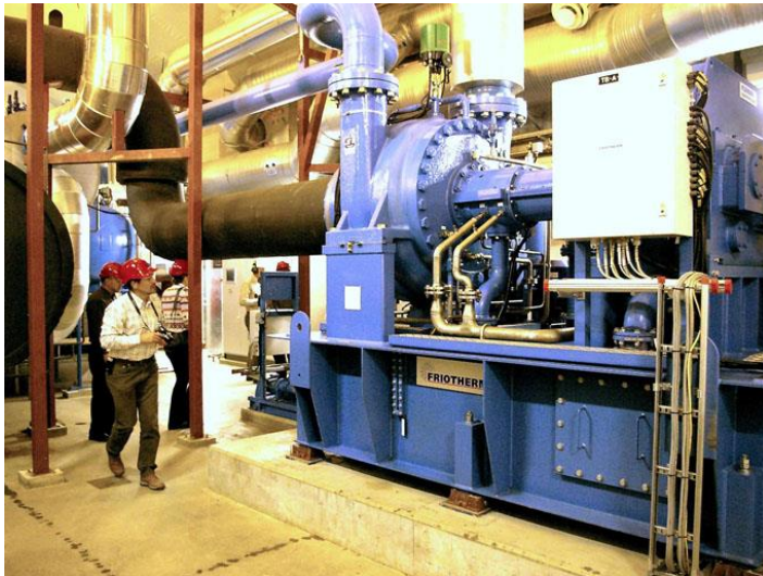
Bild 8-11 18.4 MW Wärmepumpe der Viken Fjernvarme (Fernheizsystem von Oslo [Friothersm 2008])
