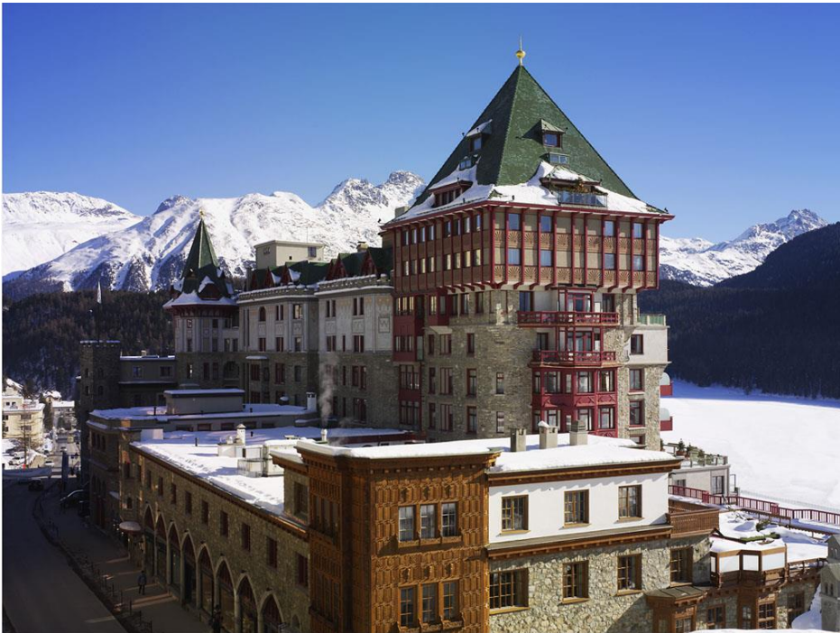
Bild 8-8 Hotel Palace in St.Moritz mit dem eisbedeckten See (rechts im Bild) als Wärmequelle [Dubacher 2007]
