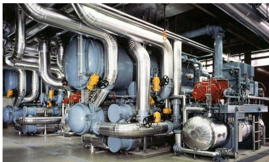
Bild 7-13 3.9 MW Ammoniakwärmepumpen an der EPFL, 1986 [Friothers 2008]
