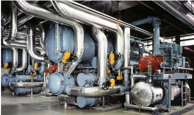
Bild 10: 7.8 MW Ammoniakwärmepumpensystem an der EPFL, 1986 [Friothers 2008]
