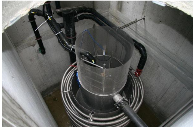
Bild 13: FEKA-Tank zur Wärmerückgewinnung aus ungereinigtem Abwasser [Kalberer, FEKA-Energiesysteme, CH-7310 Bad-Ragaz]
