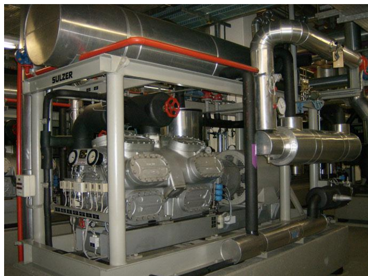
Bild 9: Eine der vier 440 kW Wärmepumpen beim Bahnhof Luzern (1984) [Axima, CH-6010 Kriens]
