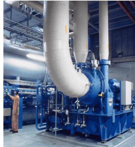
Bild 11: Eine von sechs 30 MW Sulzer Wärmepumpen der Stockholmer Fernheizung (1985) [www.friothers.ch]
