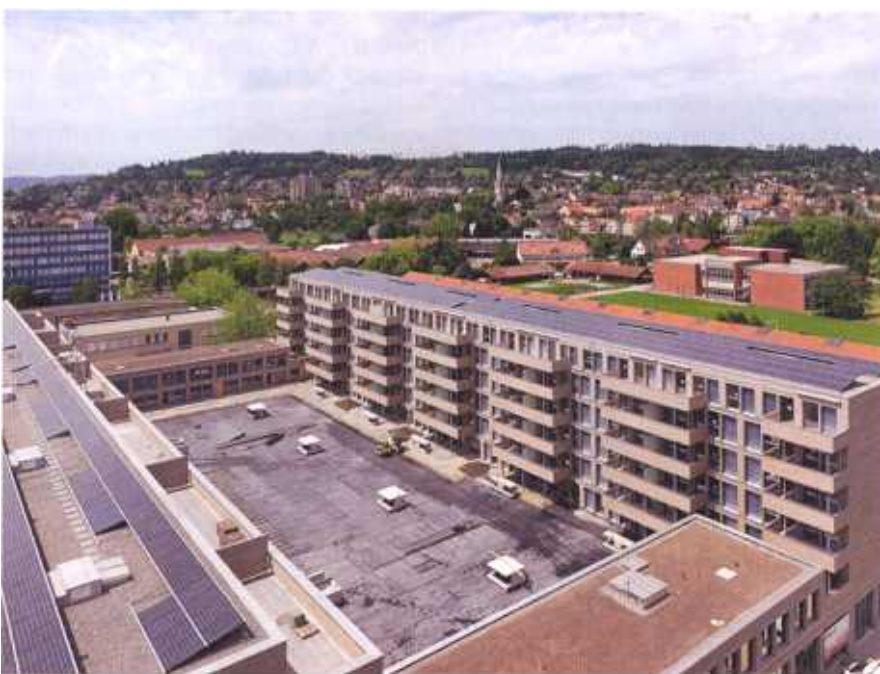
Bild 8 Eulachhof Winterthur mit Fotovoltaikzellen zum Antrieb der Wärmepumpe und der kontrollierten Belüftung.
