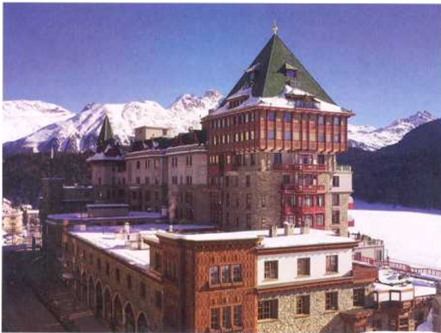
Bild 7 Hotel Palace in St.Moritz mit dem eisbedeckten See (rechts im Bild) als Wärmequelle.
