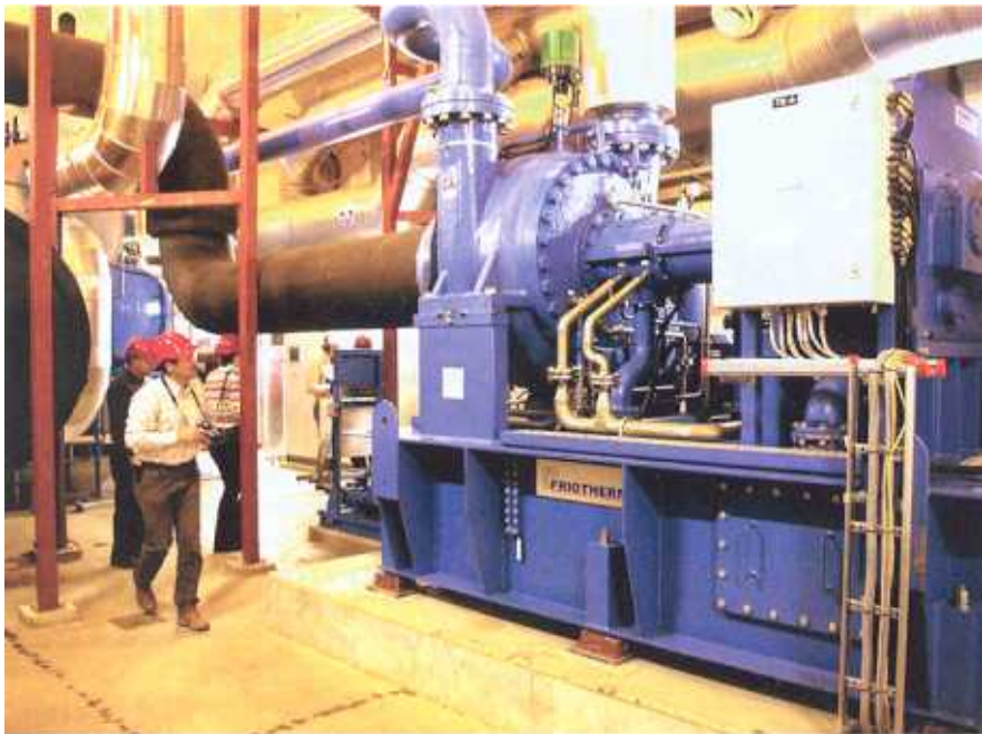
Bild 10 18,4-MW-Wärmepumpe der Viken Fjernvarme.
