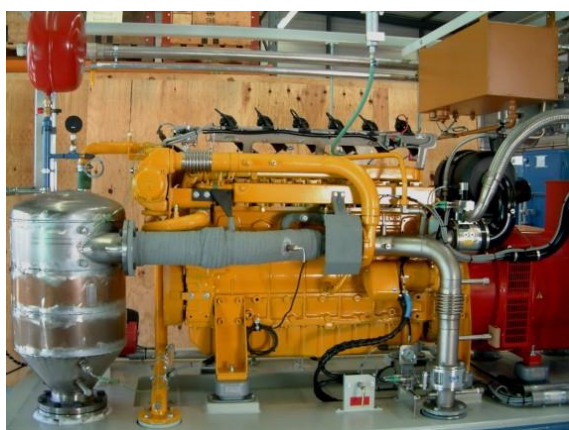
Bild 9: AGR-SwissMotor der Firma Liebherr in einem BHKW der Firma DIMAG (Bild DIMAG )
