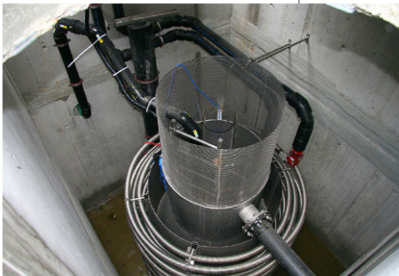
Bild 13: FEKA-Tank zur Wärmerückgewinnung aus ungereinigtem Abwasser. [Kalberer, FEKA-Energiesysteme, Bad-Ragaz]
