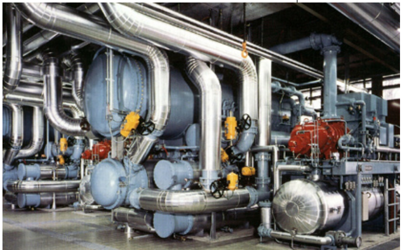
Bild 10: 7,8-MW-Ammoniakwärmepumpensystem an der EPFL 1986. [www.friotherm.com]
