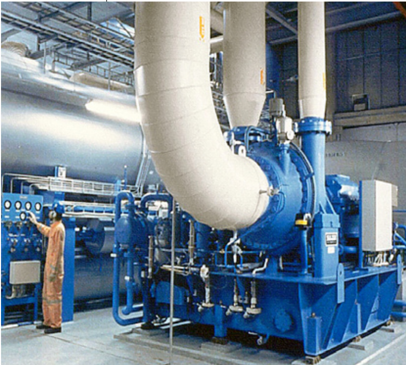
Bild 11: Eine von sechs 30-MW-Sulzer-Wärmepumpen der Stockholmer Fernheizung 1985. [www.friotherm.com]
