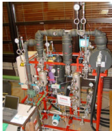
Bild 4: Versuchsanlage einer Ammoniakkleinwärmepumpe an der FH Rapperswil [ 3 ]
