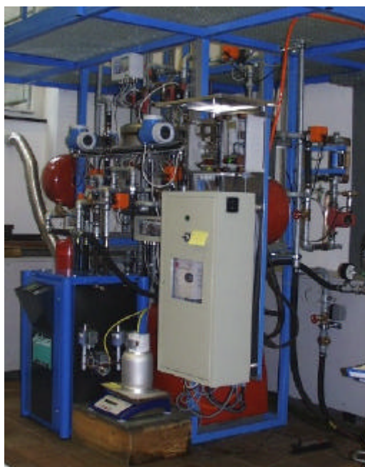
Bild 11: Dynamischer Wärmepumpenprüfstand zur Erprobung neuer Regelungs- und Betriebsüberwachungsmethoden an der ETHZ [ 6]
